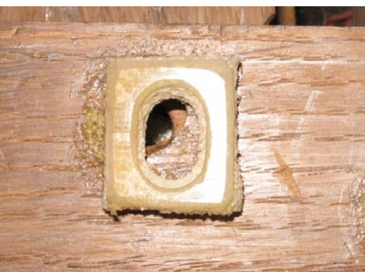
Falsch sitzende Schleifendichtung
